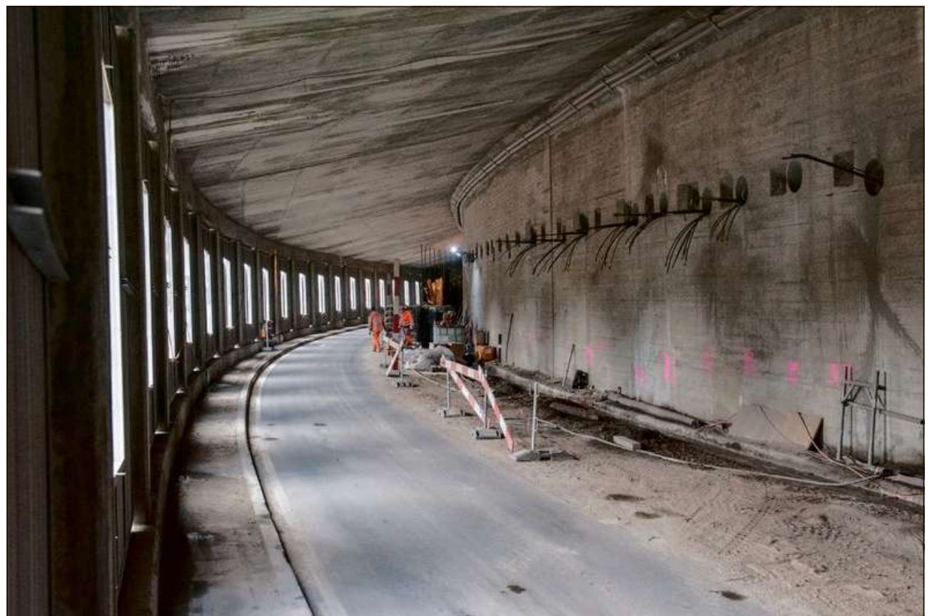
Er en l'intern vegn sanà. Uschia datti novas ancras che tanschan fin 12 meters en il culm.
